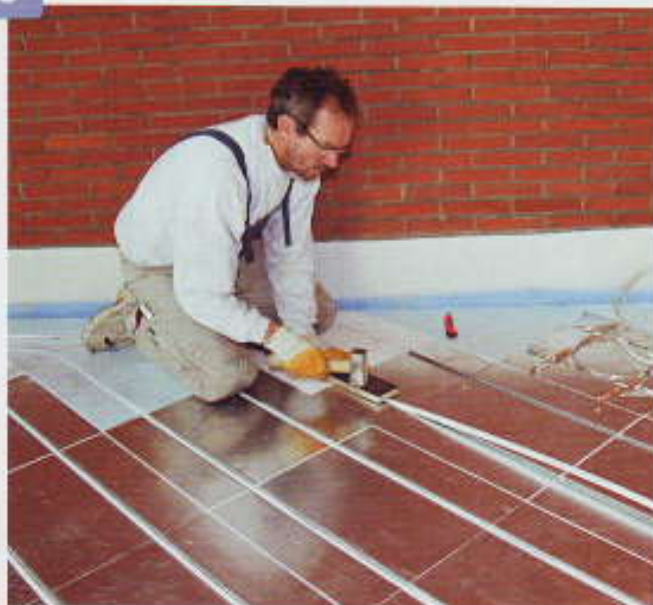
Das Dämm- und Rohrführungselement ist grundsätzlich auf der Oberseite mit Wärmeleitblechen versehen.
