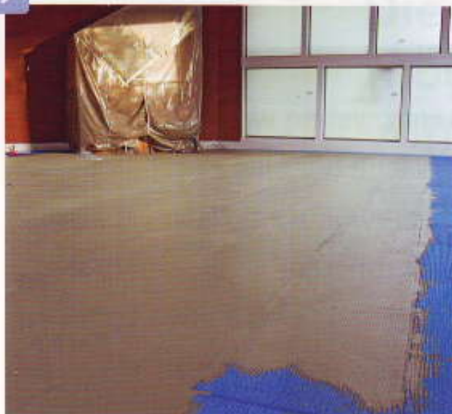
Vor der Verlegung der Feinsteinzeugplatten wurden die Belagsträger- und Entkopplungsmatten komplett abspachtelt.
