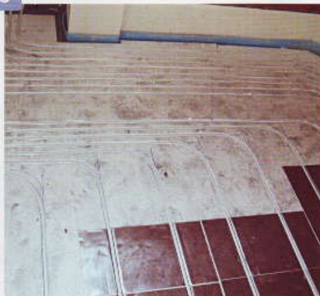
In den Randbereichen fehlt die Aluminiumkaschierung, sodass die Heizschlangen planmäßig eingearbeitet werden können.
