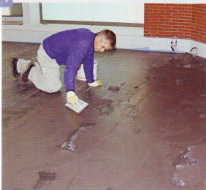
Der kunststoffvergütete Fugenmörtel wird gleichmäßig in die Fugen eingearbeitet ...
