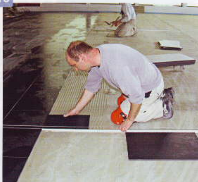
Feinsteinzeug in Schieferoptik ersetzt den einstigen Oberbelag aus Natursteinplatten.
