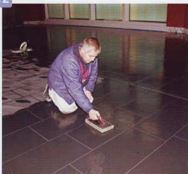
... und nach dem Antrocknen mit einem Glättschwamm sorgfältig abgewaschen.
